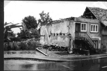
Abbruch Hauptstraße Grenzach Mi. 06.10.1982
